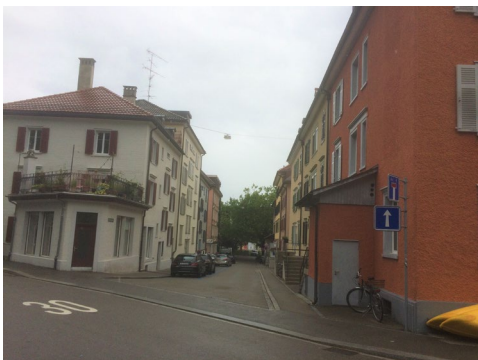
Geschossigkeit an der Brühlbleichstrasse
